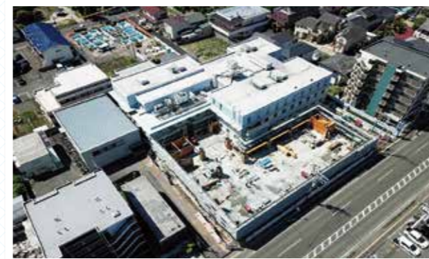
2023年5月1日 ■1階躯体工事
