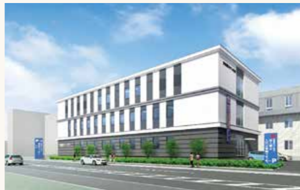
2代目がん検診センター駐車場を活用し、3代目の新がん検診センター棟を増築。令和6年（2024年）4月開所。
