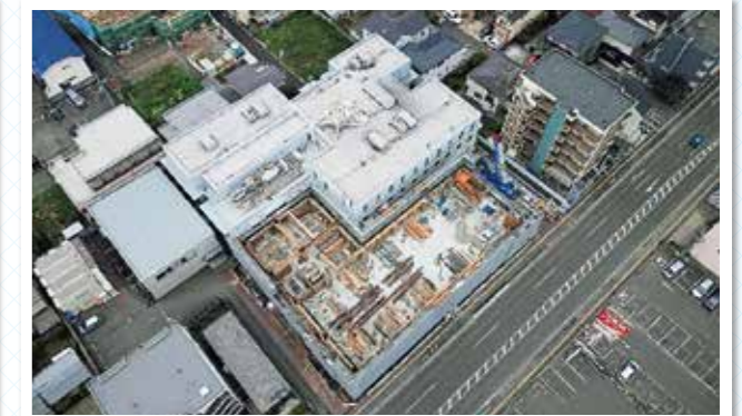
2023年6月30日 ■2階躯体工事
