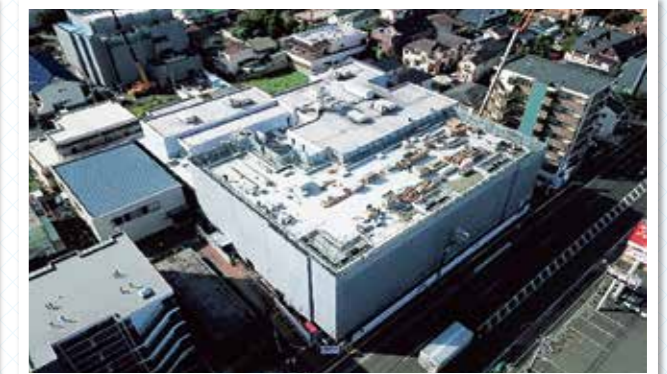
2023年10月1日 ■屋上工事
