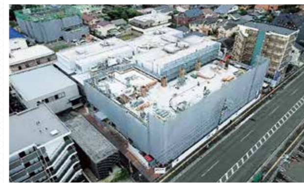
2023年8月1日 ■3階躯体工事
