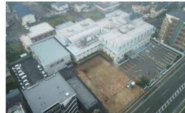
1「着工前」 撮影日:2022年10月1日
