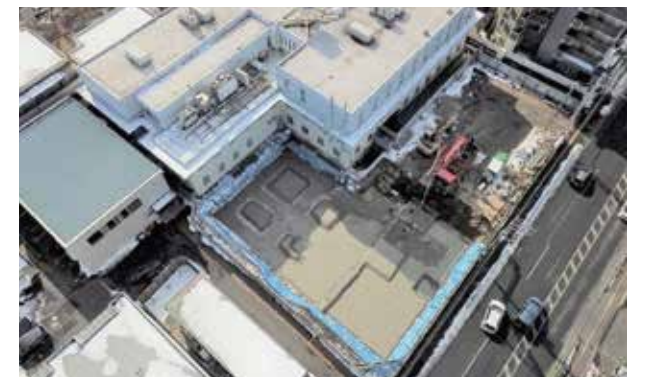
4「地業工事施工中」 撮影日:2023年2月1日
